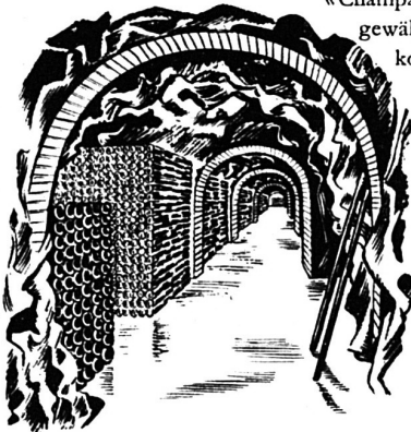
Einer unserer in den Gotthard-Fels gehauenen Keller.
