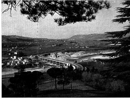
Vue panoramique du pont franchissant le Reno
