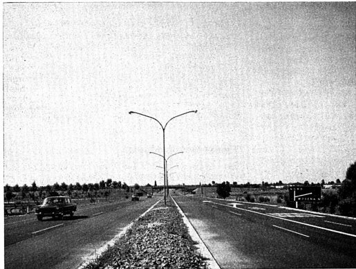
Vue de l'autoroute Bresso Modena (Svincoli)
