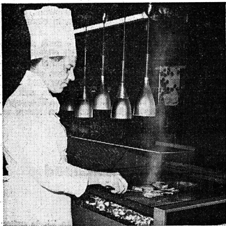
Ember-Glo-Gasgrill. Die Flammen erreichen das Grillgut durch eine Schicht von Spezialgestein, wodurch ein typisches Holzkohlengrill-Aroma erreicht wird. (Fa. Cory AG, Zürich)
