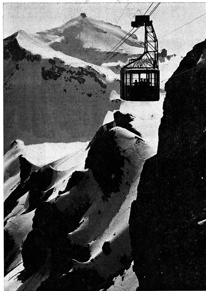
Romantik des 20. Jahrhunderts: Die Schilthornbahn zwischen der Station Birg und Schilthorn – Spannweite 1750 m. (Photo von Röll)
