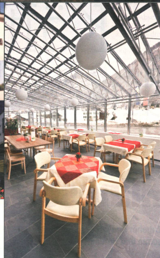
Schutz einer Terrasse durch Glaslamellen von Stebler.
