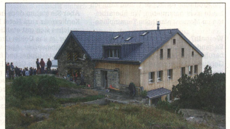
Die vollständig sanierte Kröntenhütte (UR) hat im Sommer 2014 den Betrieb wieder aufgenommen.
