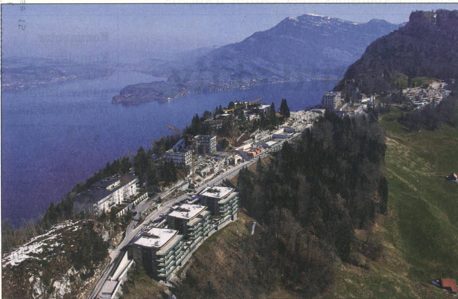
Die grösste Baustelle der Zentralschweiz: Das Bürgenstock-Resort im März 2015, fotografiert von einer Kameradrohne.
