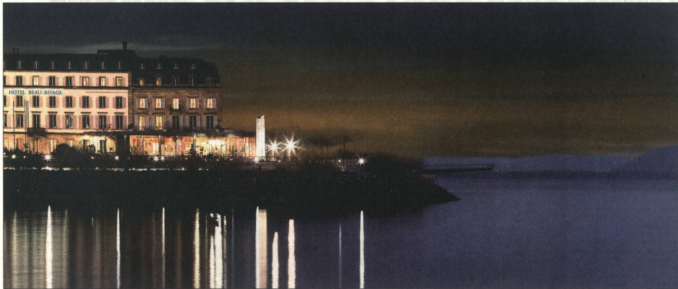
L'Hôtel Beau-Rivage de Neuchâtel dispose d'un système de pompe à eau lacustre pour refroidir ses chambres et ses frigos.
