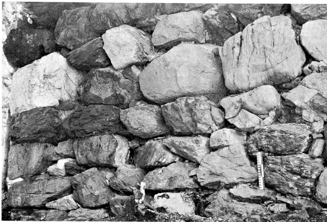
Abb. 1 Benzigen, Nordbering, Mauerstruktur.
