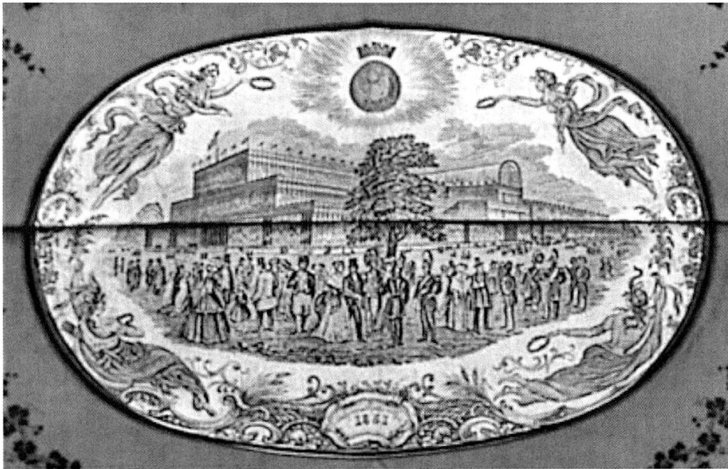
Glaspalast. Weltausstellung in London, 1851 im Hyde Park. Architekt: Joseph Paxton (viermal so gross wie der Petersdom in Rom).
