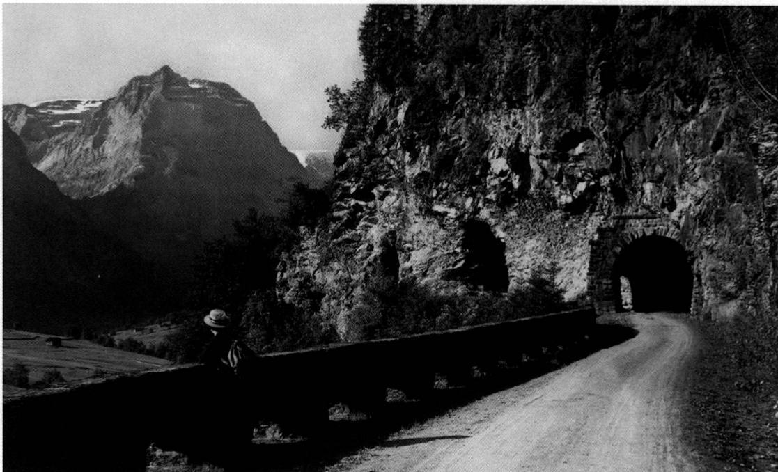
Klausenpass-Strasse: Blick Richtung Selbsanft.
