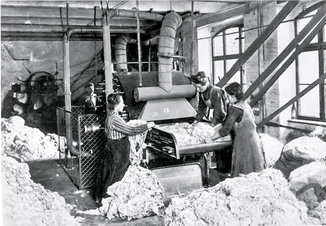
Haderneissmaschine mit Absaugvorrichtung, Darstellung aus Sommerfeld, S. 95
