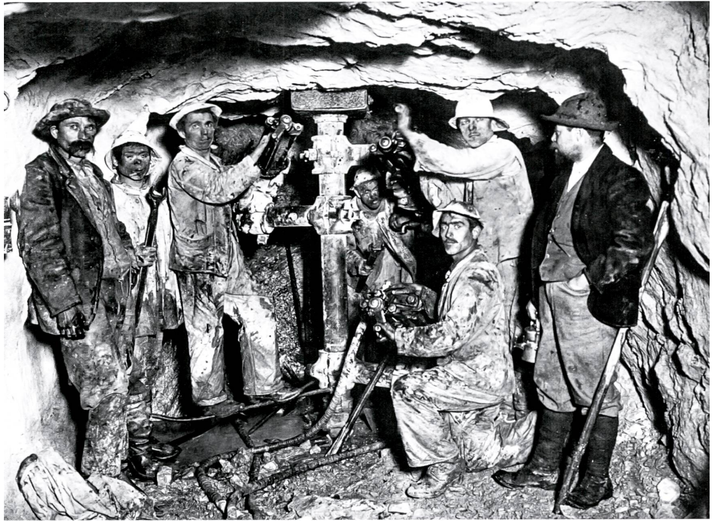
Workers constructing the Loetschberg Tunnel (1903–1913); Arbeiter beim Bau des Lötschbergtunnels (1903–1913). (Schweizerisches Sozialarchiv, Datenbank Bild + Ton, Sozarch_F_5032-Fb-0017)
