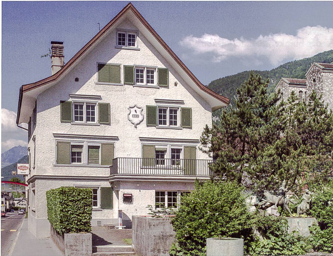
Frontseite des Gasthauses Sternen an der Landstrasse in Netstal. Gut sichtbar die eingemauerte Kanonenkugel aus den Gefechten von 1799. (Fotobuch der Stiftung Pro Netstal, Koordinaten 722715 213579)
