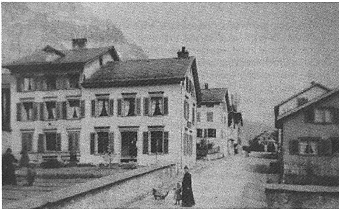
Das Elternhaus von Jakob Käser an der Asylstrasse/Reitbahnstrasse 3 in Glarus, um 1900. (aus: Oregon Historical Quarterly 3, 1980, S. 286)
