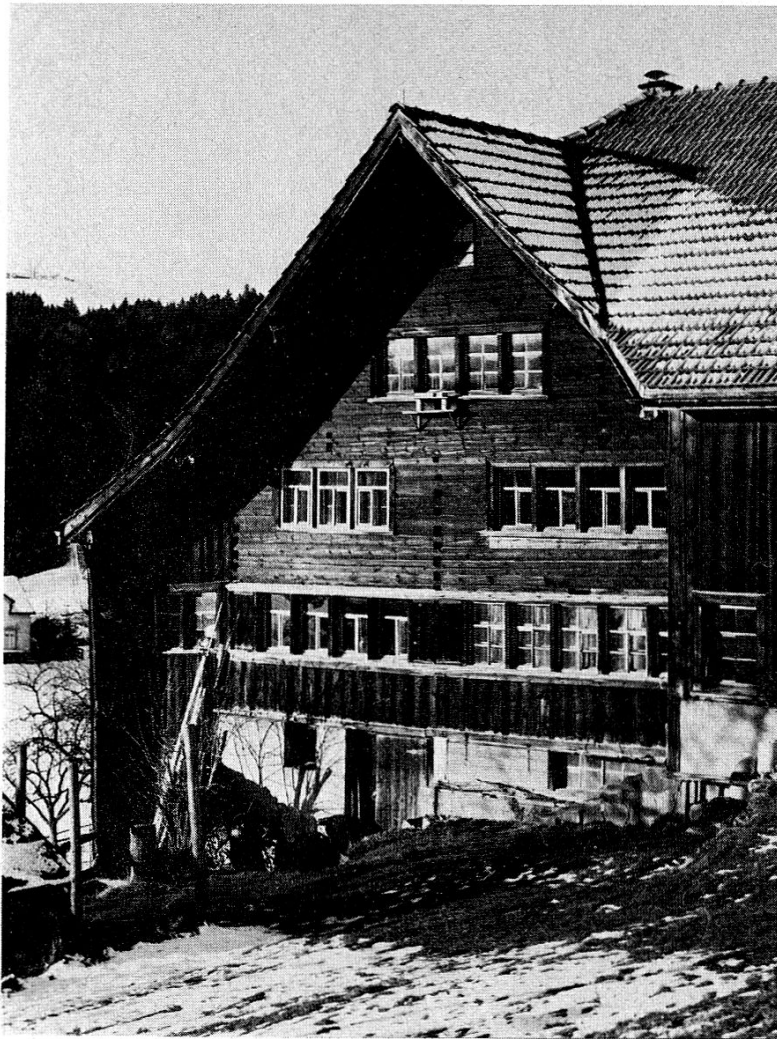
Obereggerhaus. Im Kellergeschoß rechts der Webkeller. Das erste Geschoß nachträglich vertäfert, in den Obergeschossen bleibt die Block- konstruktion sichtbar.
