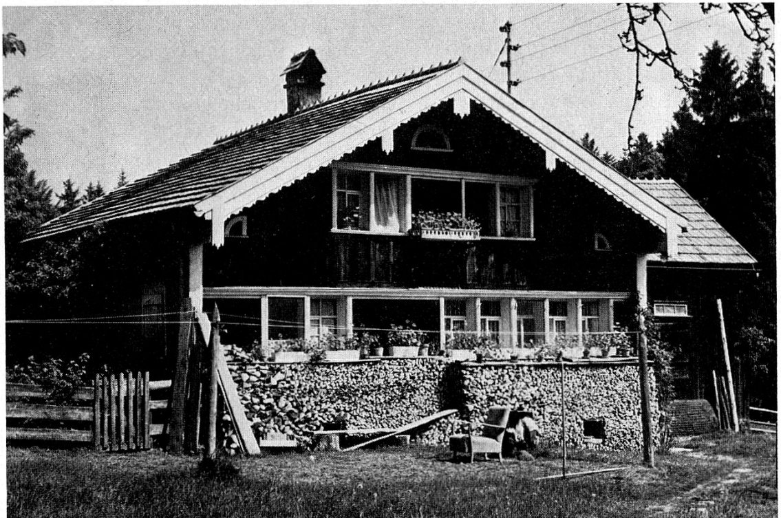
Tätschdachhaus. Pfettendach mit schwacher Neigung. Front giebelseitig. Täferung und Verkleidung der Pfettenköpfe 19. Jhd.
