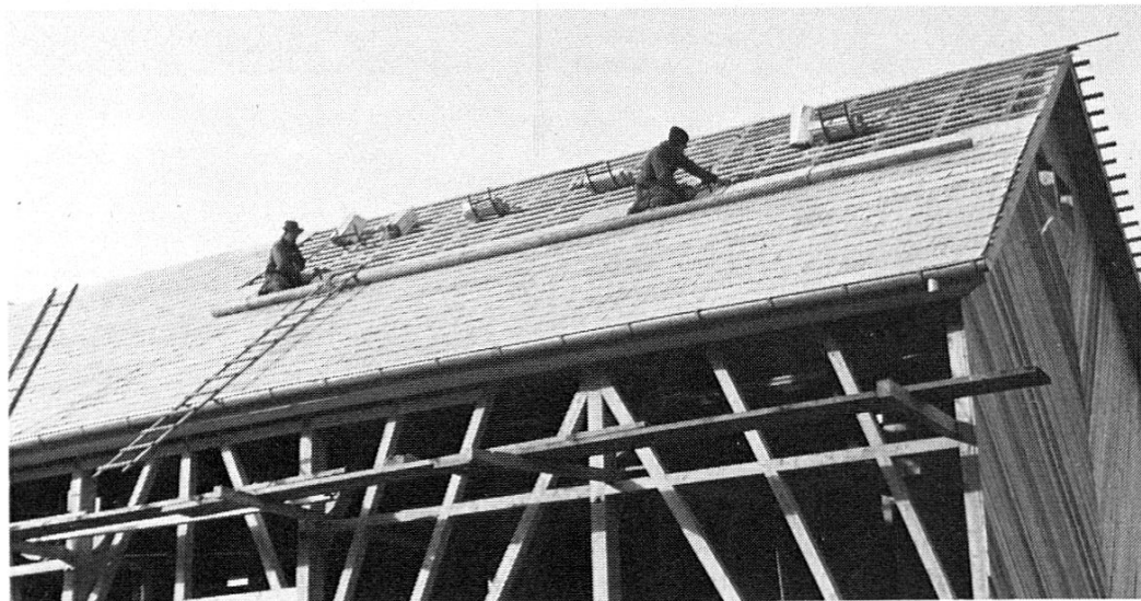
Der Dachdecker legt das Schindeldach
