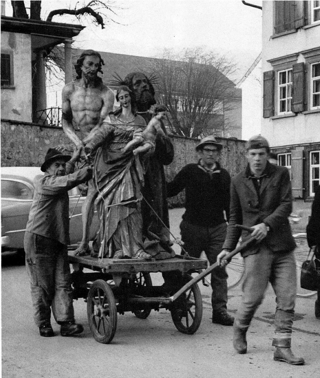
Umzug durch Arbeiter des Landesbauamtes vom Schloss zum Rathaus
