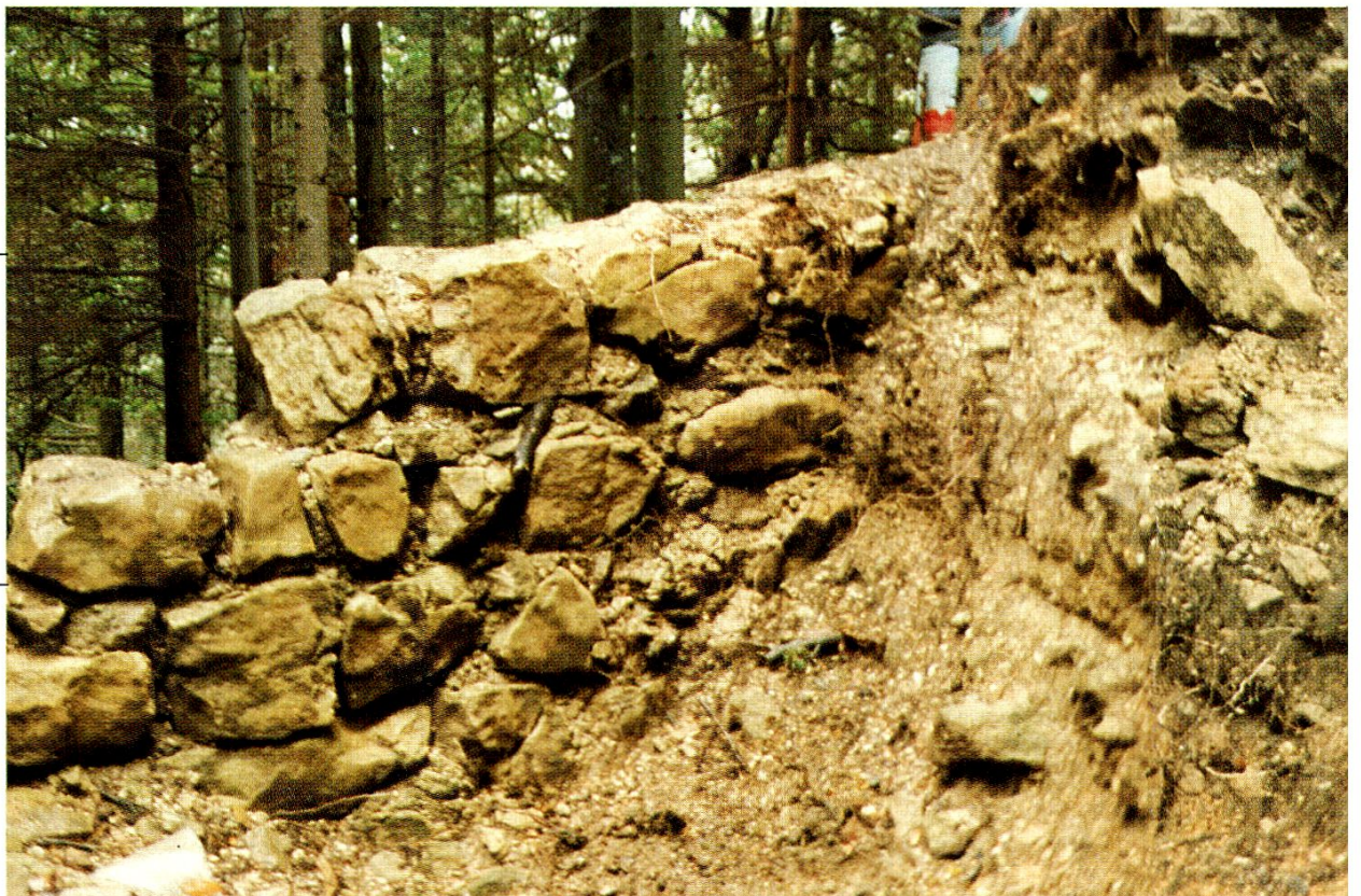
SO-Mauer Inneres Mauerhaupt; Brandrötung des inneren Mauerhauptes
