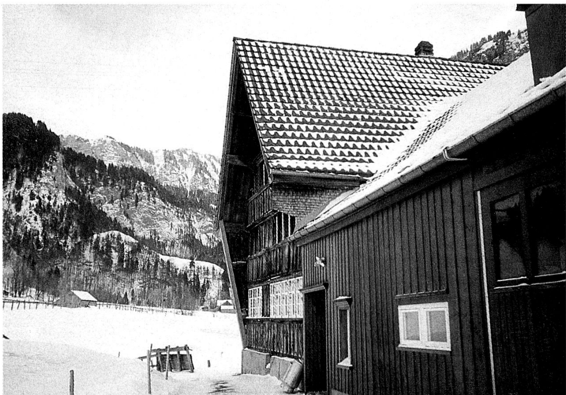
Wohnhaus «Au» in Brülisau
