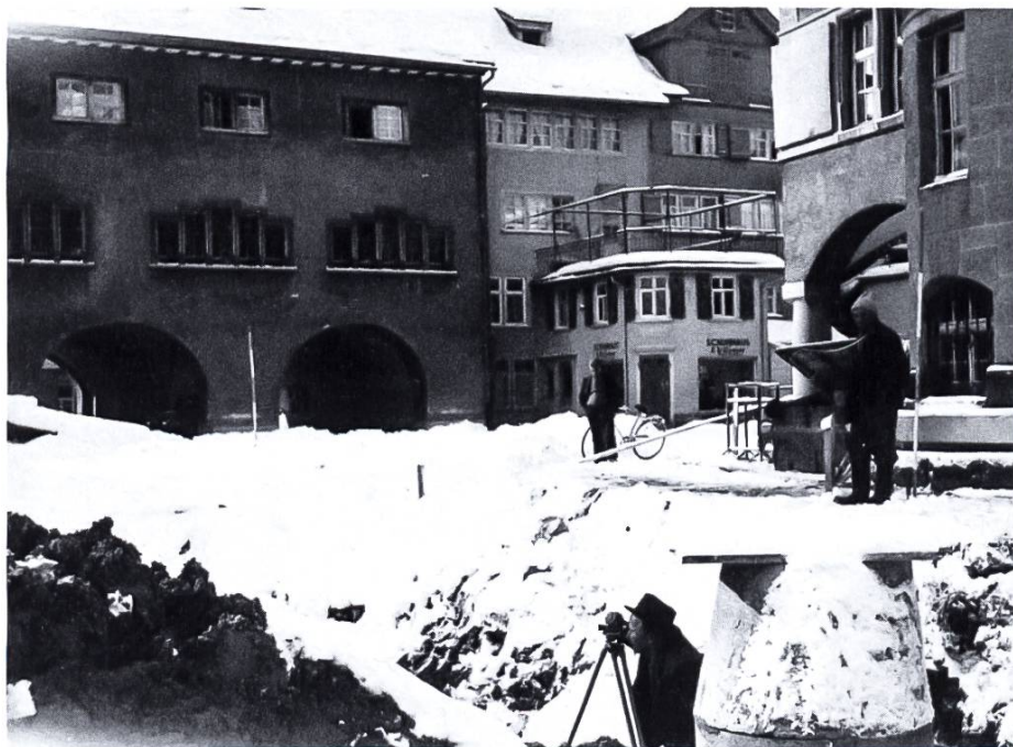
Bau der neuen Kantleigebäude, 1954–1956. (Abb. 14–17)
