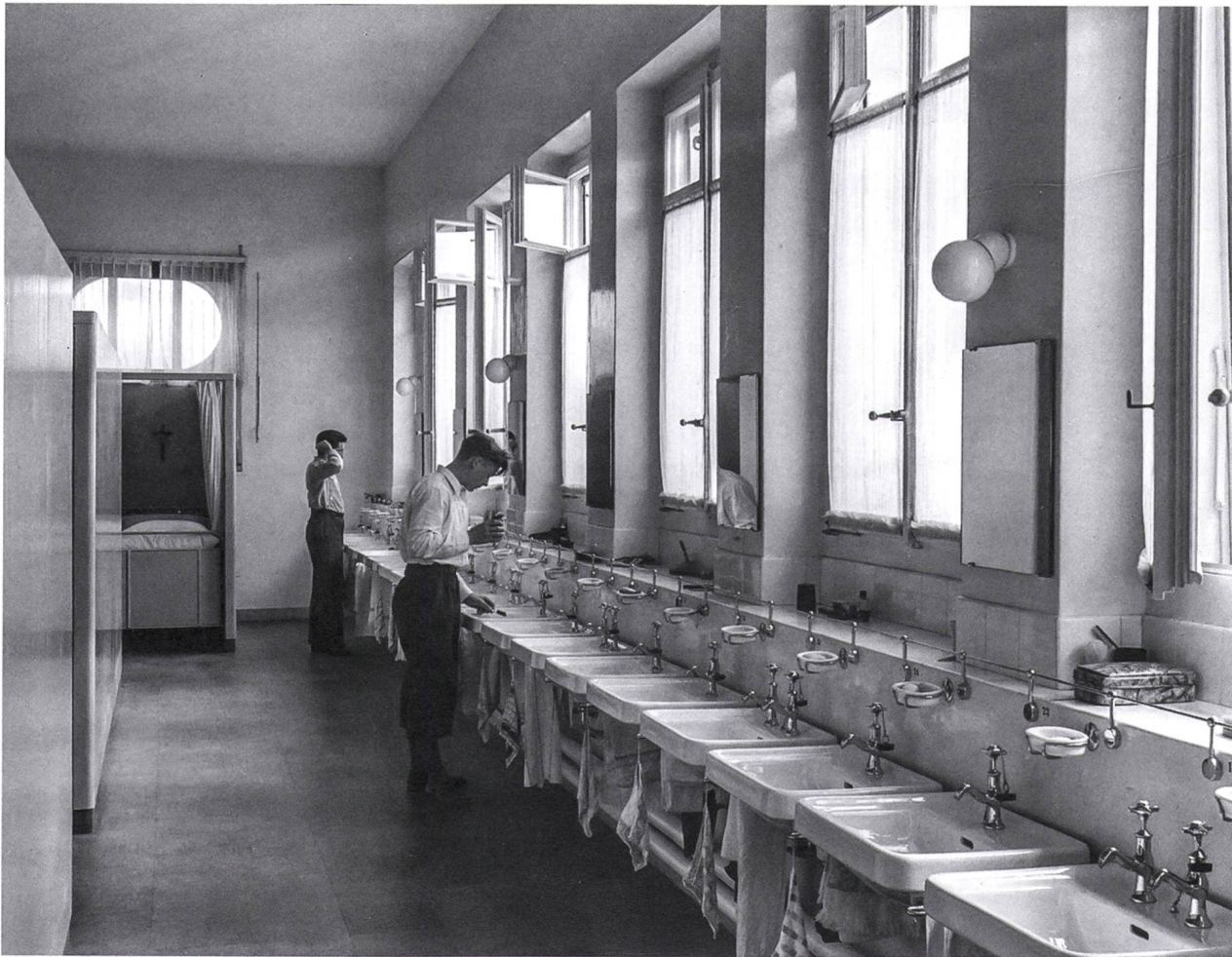
Schlafsaal im Internat mit Waschgelegenheit, 1942. Im Unterschied zu den anderen Schlafsälen verfügte hier jedes vierte Brün- neli sogar über einen Warmwasser-Hahnen. (Abb. 15)
