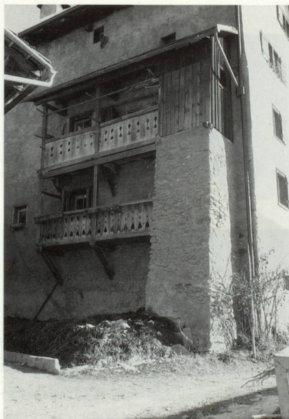
Hisli sco ei s'auda: dubel, caset da lenn per la part sura, access indirect neu dil lautget, construcziun hermetica da mir ed ins drova gnanc cavar hisli specialmein. (Scharons)
