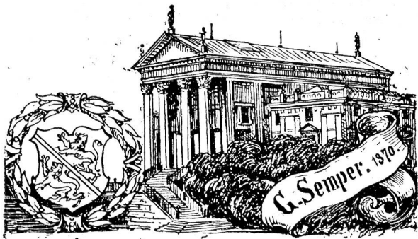
Stadthaus in Winterthur. Nach Plänen von G. Semper erbaut, eingeweiht 1870.
