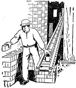
Fig. 3. Beförderung der Steine bei hohem Gefälle.
