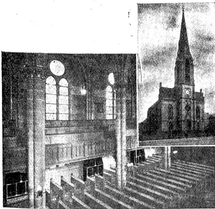
Kirche mit Gasheizöfen „Junfers“
