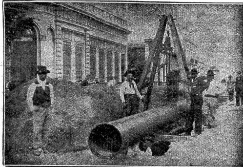
Verlegung überlapptgeschweisster Muffenrohre für die Wasserleitung von La Plata (Argentinien)
