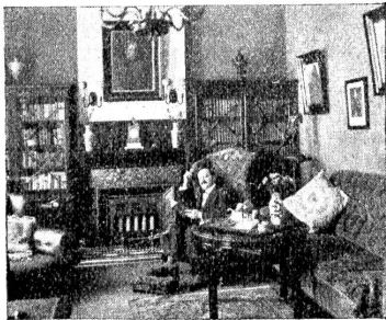
Herrenzimmer mit „Monitor“ Gas-Blüh-Heizofen.
