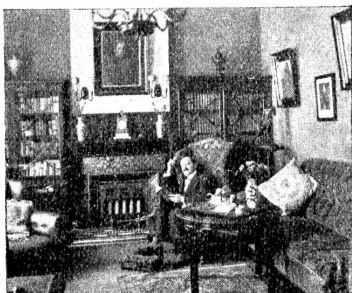
Herrenzimmer mit „Monitor“ Gas-Blüh-Heizofen.
