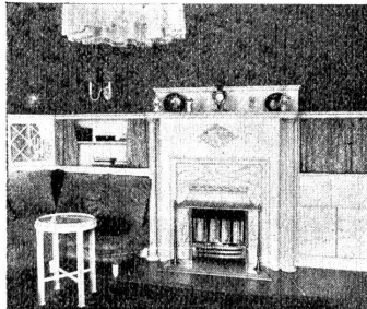
Gesellschaftszimmer mit „Monitor“ Gas-Blüh-Heizung.
