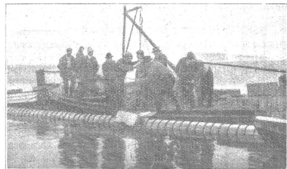
Abb. 15. Auflegen der Betonbelastung (24. Dezember 1924).
