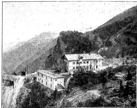
Abbildung Nr. 7. Kantine und Unterkunftsräume auf der Baustelle Garichte.
