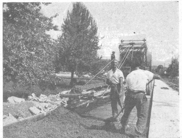
Abbildung Nr. 2. Betonmischmaschine, Selbstfahrer, mit Schwenkarm und Förder- band; Verteilung der Mischung des Unterbetons über die Eiseneinlagen. Rechts eine Fahrbahnhälfte fertig betoniert.
