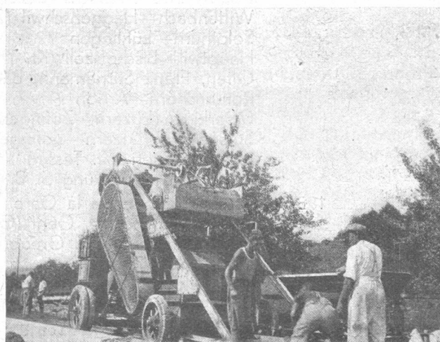
Abbildung Nr. 1. Anfuhr der Kies-Sandmischung und des Zementes zur Baustelle, mit Rollwagen; Hochziehen auf die Betonmischmaschine.
