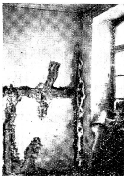
Abb. 30. Schüttsteinnische mit Fruchtkörperbildung.
