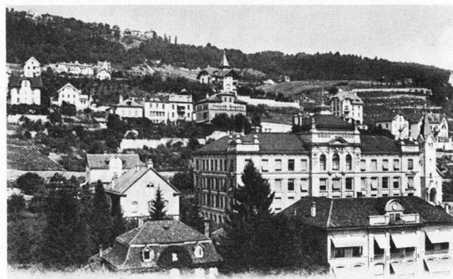
Abb. 20 Biel. Das Technikum, erbaut 1897–1900.
