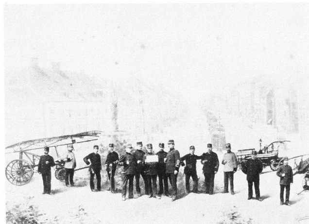
Fig. 26 La Chaux-de-Fonds. Les officiers du bataillon des pompiers et de la Police du Feu et des Constructions en 1896. Photomontage de Henri Rebmann.
