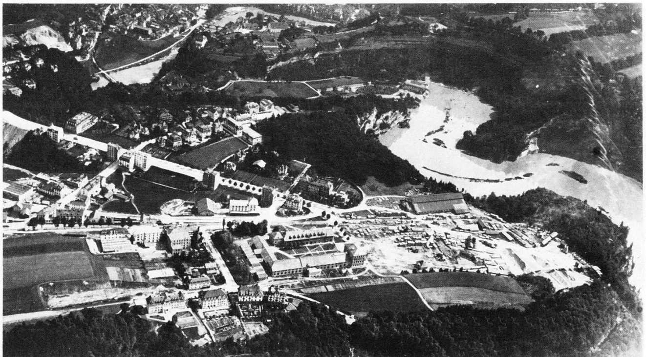
Fig. 28 Fribourg, photographie aérienne de Walter Mittelholzer (Zurich), vers 1920. Le boulevard de Pérolles et (à droite) l'installation de chantier du pont de Pérolles. Au premier plan, la zone hospitalière et universitaire (voir Fig. 23). A l'arrière-plan, le lac de Pérolles, le barrage et l'usine de la Maigrauge.
