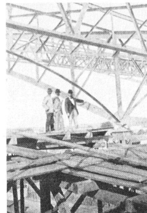
Fig. 12 Genève. Exposition nationale de 1896. Au sommet de l'échafaudage de la Halle des machines.
