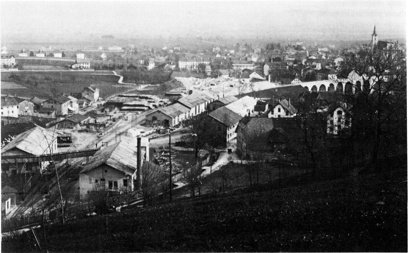
Abb. 4 Grenchen. Bauinstallation am Südportal des 1911–1915 erstellten Grenchenbergtunnels (Bahnlinie Lengnau–Grenchen-Münster). Links das Arbeiter-Barackendorf «Tripolis». Photo 1912.
