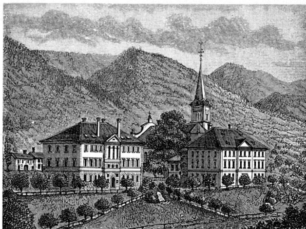
Abb. 42 Grenchen. Erhöhtes «Forum» über der Bielstrasse. Kath. Kirche mit neuem Helm von 1868. Schulhaus I (rechts), erbaut 1844–1846. Schulhaus II (links), erbaut 1881–1883. Holzstich um 1885.
