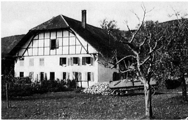
Abb. 24–27 Grenchen. Örtliche Bautradition und Wiederaufnahme im Zeichen des Heimatschutzes. – Abb. 24: Gutshof Garnbuchi, Stadstrasse Nr. 60, erbaut 1838 für Garnbleicher Anton Schild, der hier 1851 ein Uhrenatelier samt Lehrwerkstätte einrichtete. Photo um 1950. – Abb. 25: Untere Mühle, erbaut 1834 für Urs Josef Hugi. Dahinter entstand ab 1896 die Uhrenfabrik von Adolf Schild-Hugi, Gatte von Hugis Enkelin. Photo aus Heimatbuch Grenchen , 1949, S. 363. – Abb. 26: Gebäude der Landwirtschaftl. Genossenschaft beim Bahnhof Grenchen-Süd, erbaut 1914 von Otto Rudolf Stalder. Photo 1986. – Abb. 27: Eigenes Wohnhaus des Architekten Carl Burkhard (1892–1971), Glockenweg 3, erbaut 1924. Photo aus Burkhard's Werbespekt 1931. Vgl. Abb. 19.
