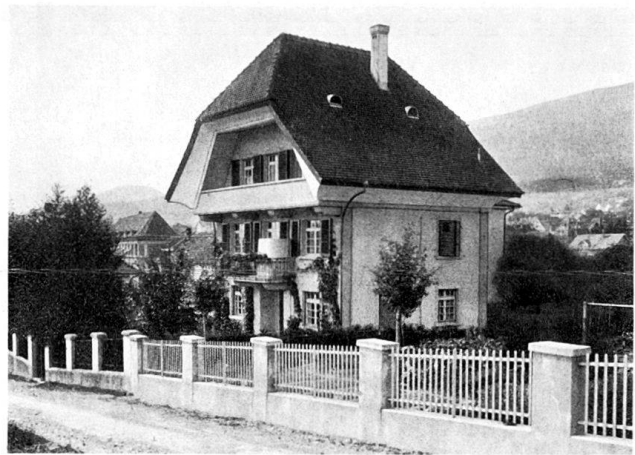
Abb. 27 Grenchen. Wohnhaus Burkhard.
