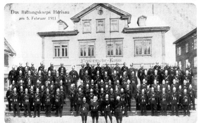
Abb. 9 Herisau. Das Feuerwehrkorps 1911 vor dem 1886–1888 erbauten Feuerwehr-Haus an der Kasernenstrasse Nr. 7.
