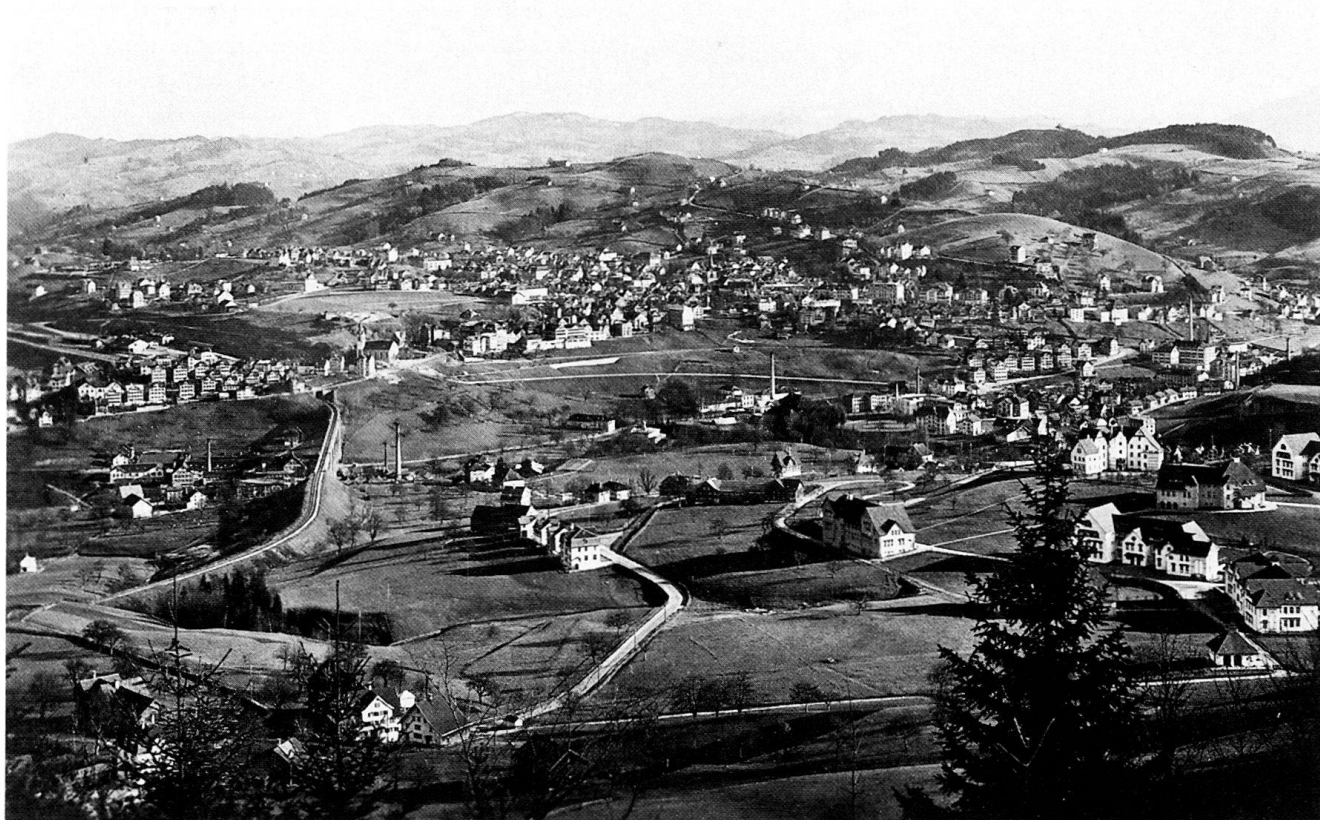
Abb. 45 Siedlungsgebiet Herisau, durchquert von der 1907–1910 angelegten Bodensee–Toggenburg-Bahn (auf Damm und Brücke im Mittelgrund links). Vorne rechts die Bauten der Appenzellischen Landesirrenanstalt Krombach (vgl. Abb. 41). Foto um 1920.
