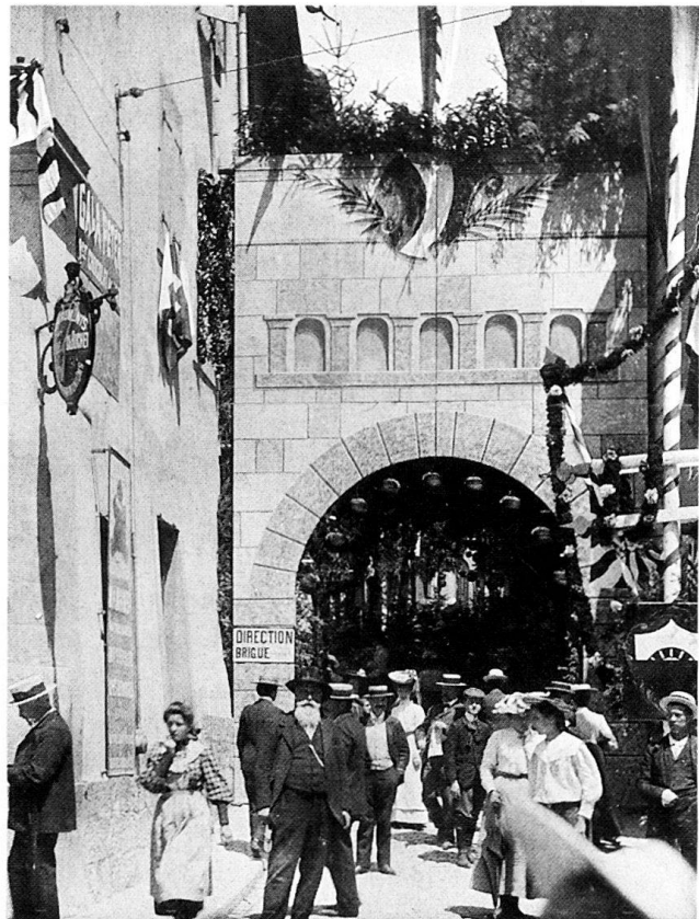
Fig. 14 Tête sud du tunnel. Voir fig. 13.
