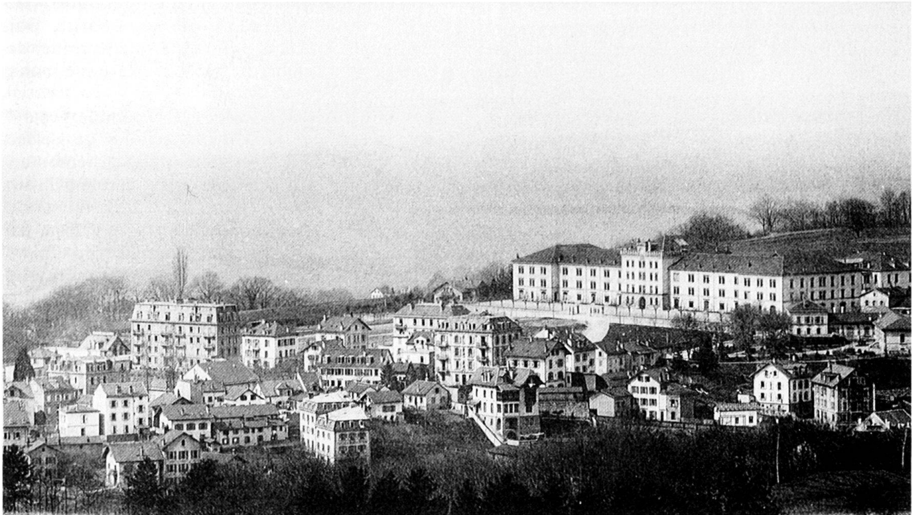
Fig. 72 Le quartier de la Pontaise vu du Signal, vers 1903 (2.6.8); au second plan, les casernes, de l'architecte Louis Dériaz. Carte postale ancienne.
