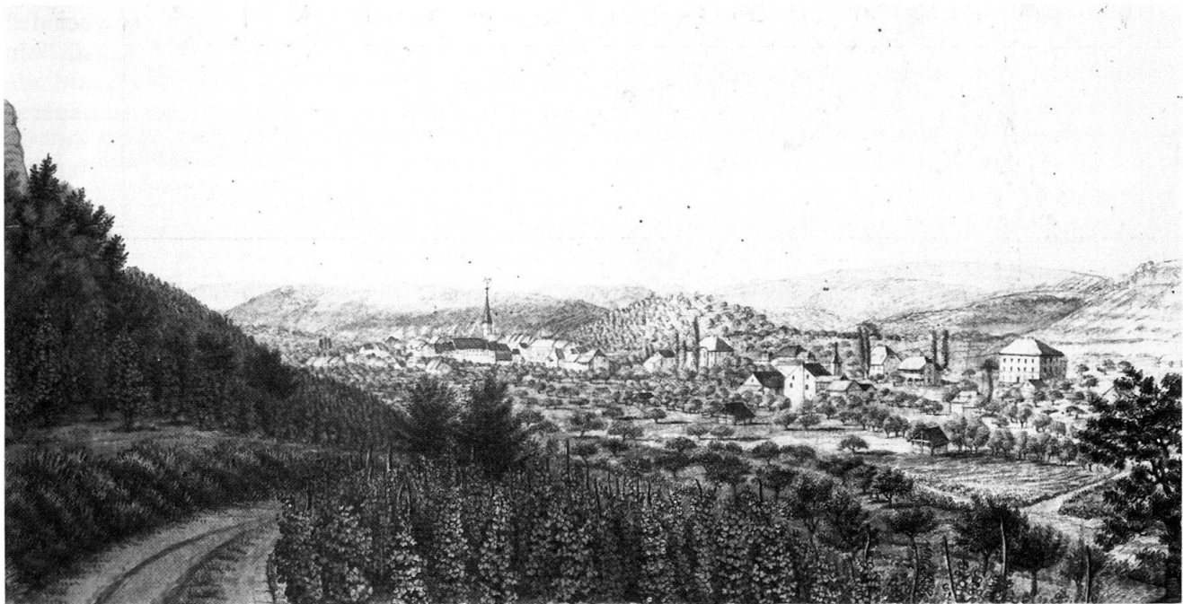
Abb. 19 Liestal um 1840, von Nordwesten. Im Mittelgrund die Ergolz-Talebene mit der vorstädtischen Bebauung der 1830er Jahre an der Rheinstrasse: rechts der dominierende Kubus der Villa Hug, links der Gasthof Falken. Dazwischen vorgelagert Feldmühle und Feldsäge. Aquarellierte Feder- und Bleistiftzeichnung. Wahrscheinlich von Samuel Gysin (1786–1844). Ausschnitt.
