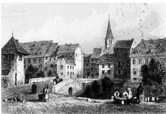
Abb. 22 Liestal. Unterer Stadteingang mit Orisbachbrücke und der 1775–1779 erbauten Stadtschreiberei (rechts). Radierung von H. Winkler um 1830.
