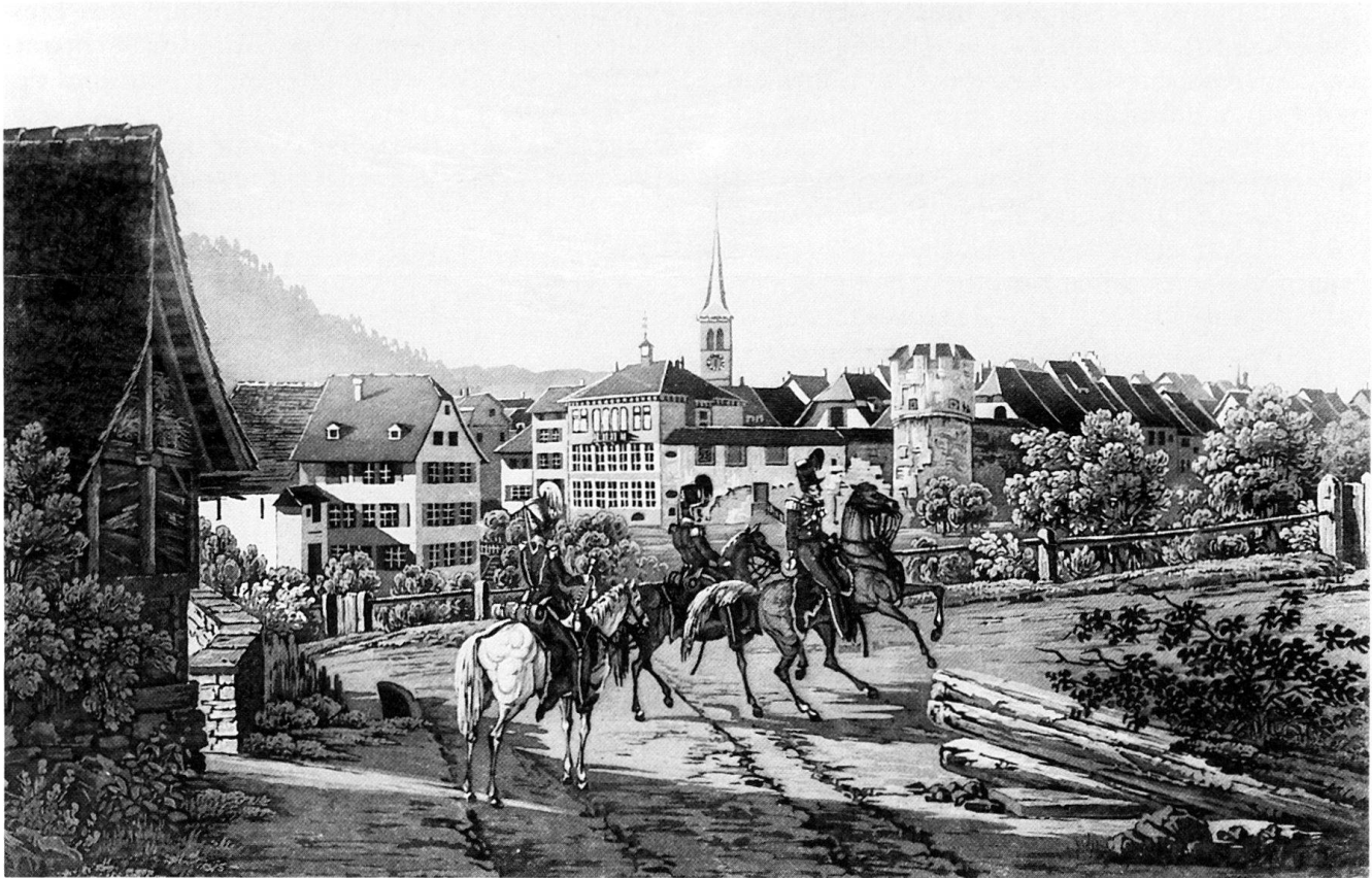
Abb. 23 Liestal. Westansicht, mit der 1834 zum Kant. Regierungsgebäude umgebauten Stadtschreiberei (vgl. Abb. 22). Zeichnung und Stich von C. C. Rordorf.
