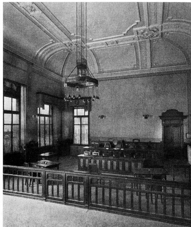
Ill. 40 Locarno. Via della Pace no 6. Sala delle udienze del Pretorio, dove nel 1925 si tenne la conferenza della Pace.
