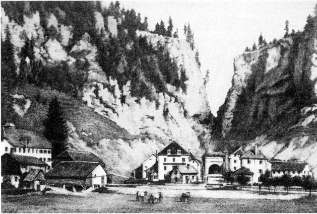
Fig. 18 Le Col des Roches, avec le tunnel de la route de France, ouverte en 1850. Tiré de: Huguenin-Lassauguette 1890.
