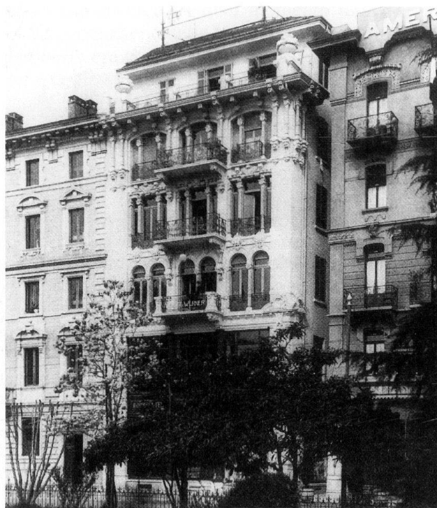
Ill. 71 Lugano. Grandi magazzini Milliet & Werner, del 1907, di Giuseppe Bordonzotti coadiuvato da Henri Pelet. Struttura in ferro rivestita di pareti in pietra artificiale.
