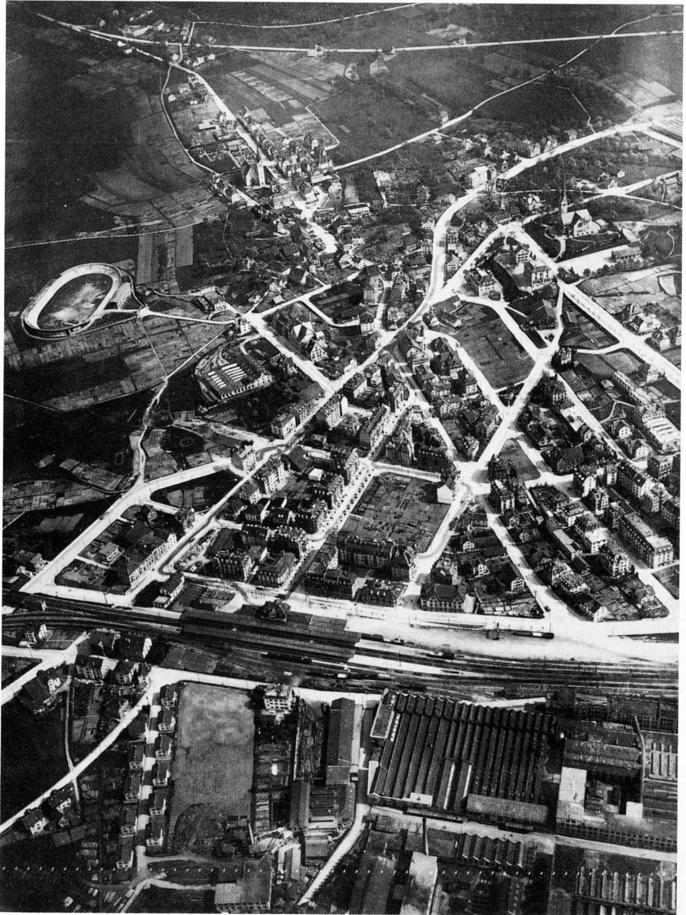
Abb. 72 Zürich-Oerlikon. Foto Ad Astra-Aero um 1920. Kerngebiet mit Bahnhof. Maschinenfabrik (r. u.), künftiger Marktplatz (Mitte), Rennbahn (l. o.), katholische Kirche (l. o.), reformierte Kirche (r. o.). Ausfallstrasse von Zürich-Unterstrass (Bildecke r. o.).
