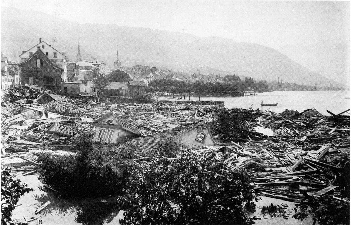
Abb. 16 Die Vorstadt am Tag nach dem Seeufereinbruch von der Passage zum Dampfschiffsteg aufgenommen. Lichtdruck von A. Synnberg in Luzern, 6. Juli 1887. Im Vordergrund sind Giebel und Dachkerker des zerstörten Hotels Zürcherhof noch zu erkennen.
