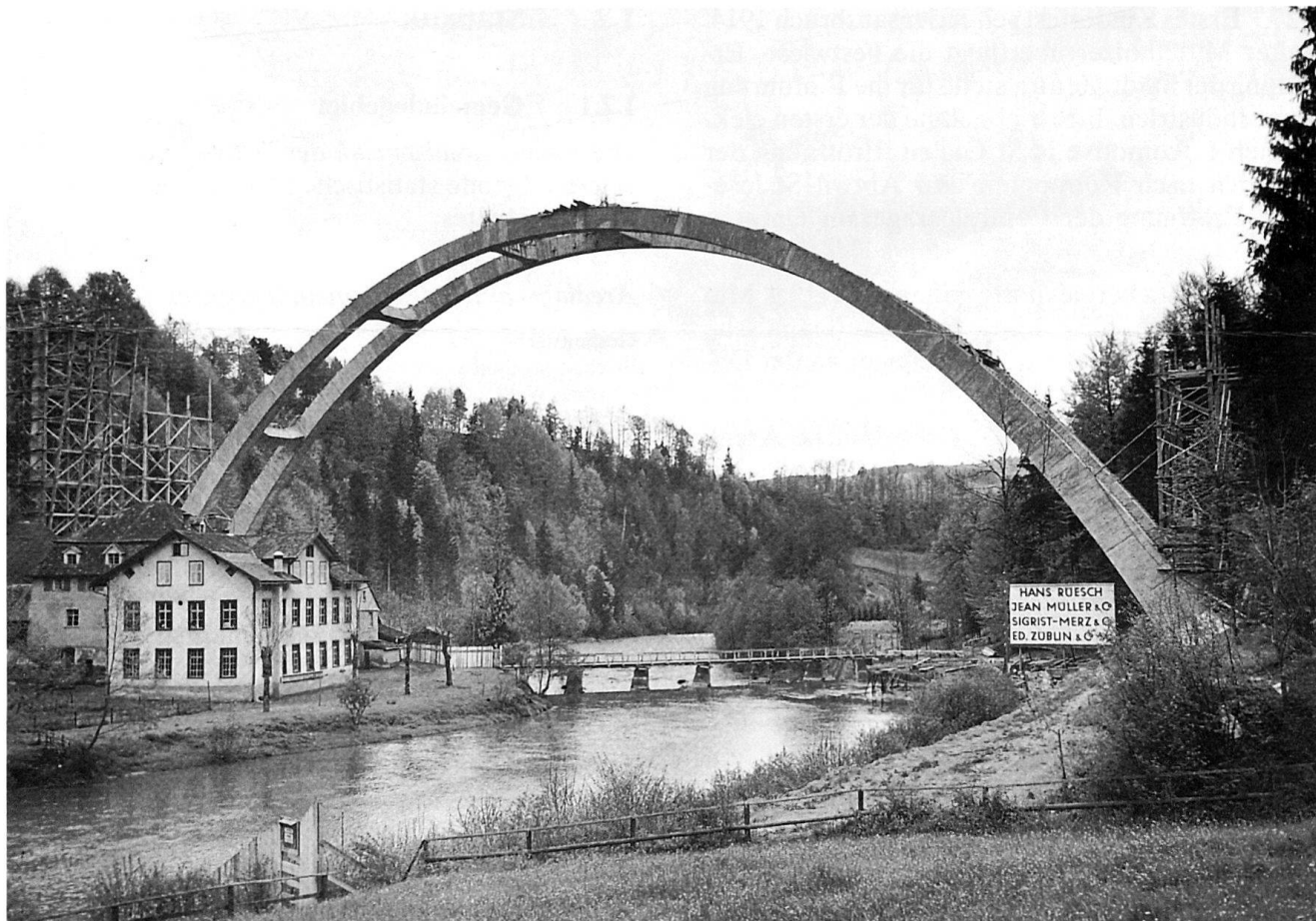
Abb. 16 St. Gallen. Fürstenlandbrücke in 134 m weitem Bogen über die Sitter, erbaut 1938–1941 nach Projekt von Ingenieur Karl Kobelt, dem späteren Bundesrat. Vollendeter Betonbogen 1939. Fotografie.
