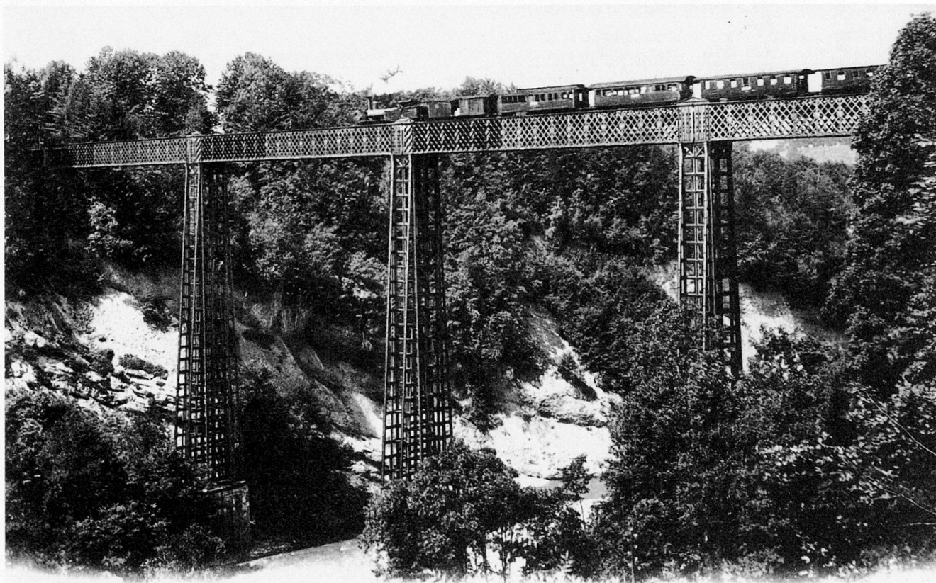
Abb. 52 und 53 St. Gallen. Sitterbrücke der Vereinigten Schweizerbahnen. 1853–1856 erbaut von den Ingenieuren Louis Caspard Dollfus und Carl von Etzel. 165 m lange eiserne Gitterträgerbrücke mit Pfeilern aus Gusseisenelementen. Erster derartiger Brückentypus auf dem europäischen Kontinent nach dem Vorbild der Londoner Britanniabrücke. Postkarte um 1910 und Konstruktionsdetails aus: F. Heinzerling, Die Brücken aus Eisen , Leipzig 1870.
