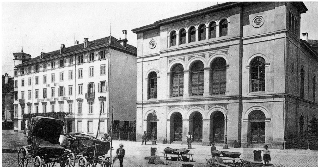
Abb. 43 St. Gallen. Städtisches Theater am Bohl, 1855–1857 erbaut von Johann Christoph Kunkler. 1971 abgebrochen. Fotografie um 1870.
