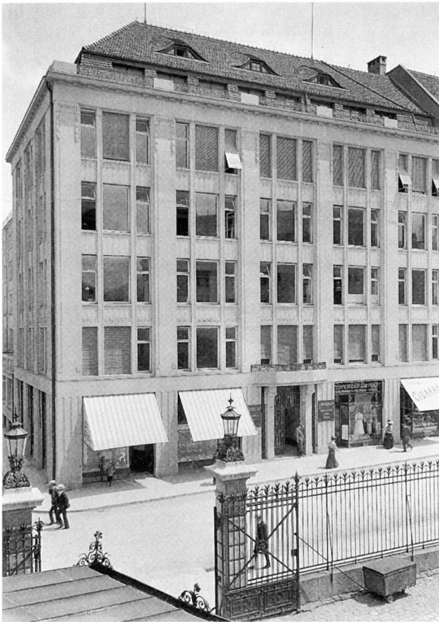
Abb. 59 und 60 St. Gallen. Stickereigeschäftshaus Labhard & Cie. Ecke Kornhausstrasse/Merkurstrasse. 1907/1908 erbaut von Pflughard & Häfeli, Zürich. Eisenbetonbau mit Sandsteinverkleidung. Fassaden- und Hofansicht 1909.
