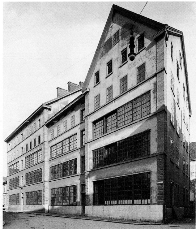
Abb. 33 «Industriegebäude», erbaut zwischen 1866 und 1872 im Auftrag und nach Konzept von Heinrich Moser, mit mietbaren Werkstätten für modernisierungswillige Gewerbetreibende und kapitalarme Unternehmensgründer. Später Teil der Kammgarnspinnerei. Fotografie Koch, 1912.
