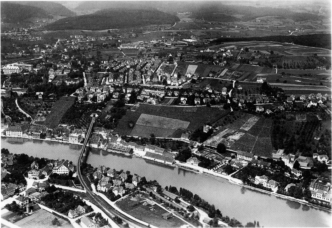
Abb. 47 Flugaufnahme der Rheinhalde von Südsüdosten, um 1920, von Walter Mittelholzer. Oben wieder das Emmersbergquartier (vgl. Abb. 46). Nun sichtbar der südliche, zum Rhein orientierte Teil des Quartiers, situiert auf schmaler Terrasse, früher – mit der Halde darunter – als Fischerhäuserberg bezeichnet. Links an der Krette einige vornehmere Häuser, sonst jedoch einfache Bauten: bei dem sich heraushebenden langgestreckten Einfamilien-Zeilnhaus (Bildmitte) handelt es sich um ein Arbeiterhaus der Kammgarnspinnerei. Unten am Fluss die alte, von der Brücke der Etwilerlinie durchquerte Fischerhäusern-Vorstadt, beginnend beim Güterhof (links), endend mit dem äusseren Salzstadel (in Bildmittelachse). Links vom letzteren wurden einst die Salzfüässer ausgeladen; rechts von ihm, vor dem Haus zur Sommerlust, befand sich 1825 bis 1842 die Dampfschiffllände. Rechts aussen ein Teil des 1860 erbauten, 1900 erweiterten Gaswerkes: eine industrielle Enklave am sonst bukolischen Rheinufer. Vor dem Gaswerk die Lindlipromenade, aufgeschüttet gegen das Jahrhundertende, als die östliche Ausfallachse Schaffhausens (die alte Wein-, Post- und Salzstrasse nach Stockach und Ulm) neu geführt wurde: ab Felsgasse wurde in der Verlängerung der Rheinhaldestrasse eine Uferstrasse nach Büsingen gebaut.
