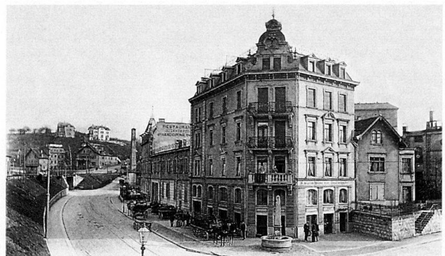
Abb. 52 Die 1894–1896 abgetiefte und nach Norden bis zur Etwiler-Unterführung (hinten links) verlängerte Bahnhofstrasse (vgl. Abb. 5). Rechts der Stauffacherhof, erbaut 1897–1898.
