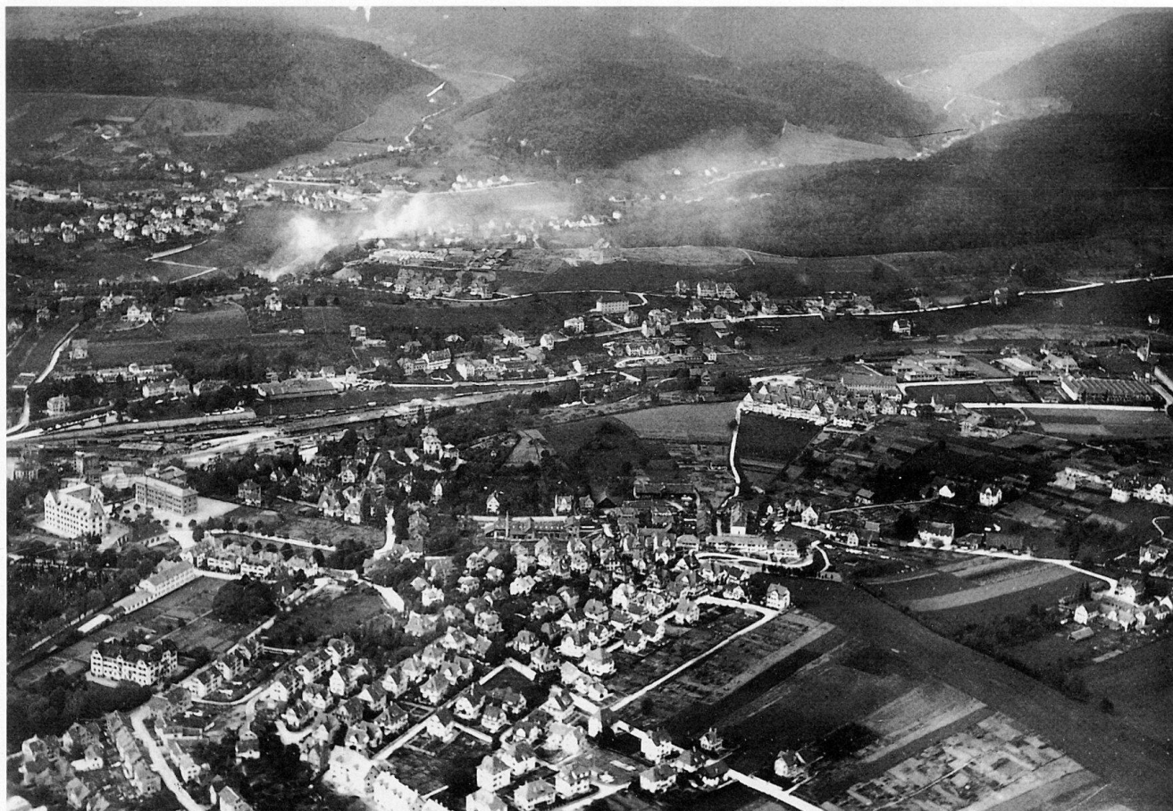
Abb. 46 Flugaufnahme des Emmersberges von Südosten, kurz nach 1920, von Walter Mittelholzer. Im Vordergrund das Wohnquartier auf dem oberen Emmersberg, mit der Alpenstrasse als Haupt-Erschliessungssachse (diagonal im Bild). Links die Terrasse des unteren Emmersberges, mit dem Bürgerasyl, der Seilerei Oechslin, der Wohnsiedlung Rosenberg (erstes Werk der Gesellschaft für Erstellung billiger Wohnhäuser) und den zwei Schulhäusern oberhalb der Altstadt (Kantonsschule links, Elementarschule rechts). In mittlerer Bildhöhe zieht sich der Rücken des Ungarbühles nach rechts, vom Emmersberg durch eine Mulde – genannt «Gruben» – getrennt. Auf der Kuppe der massive Doppelriegel der GEbW-Wohnkolonie «Hohenstoffel» (mit übergiebelten Ecktrakten). Rechts davon, nördlich unterhalb des Ungarbühls, die Terrasse des Ebnat mit dem gleichnamigen Industriequartier. Quer durch das Bild sich ziehend das Fulachtal, mit Bahnlinie (links der Güterbahnhof) und mit der Hochstrasse, der Ausfallachse Richtung Thayngen–Stuttgart. Die Dunst- und Rauchwolke im Hintergrund zeigt den kaum sichtbaren Einschnitt des Mühlentals an; herwärts der Geissberg, jenseits die Breite. Vergleiche auch Abb. 47.
