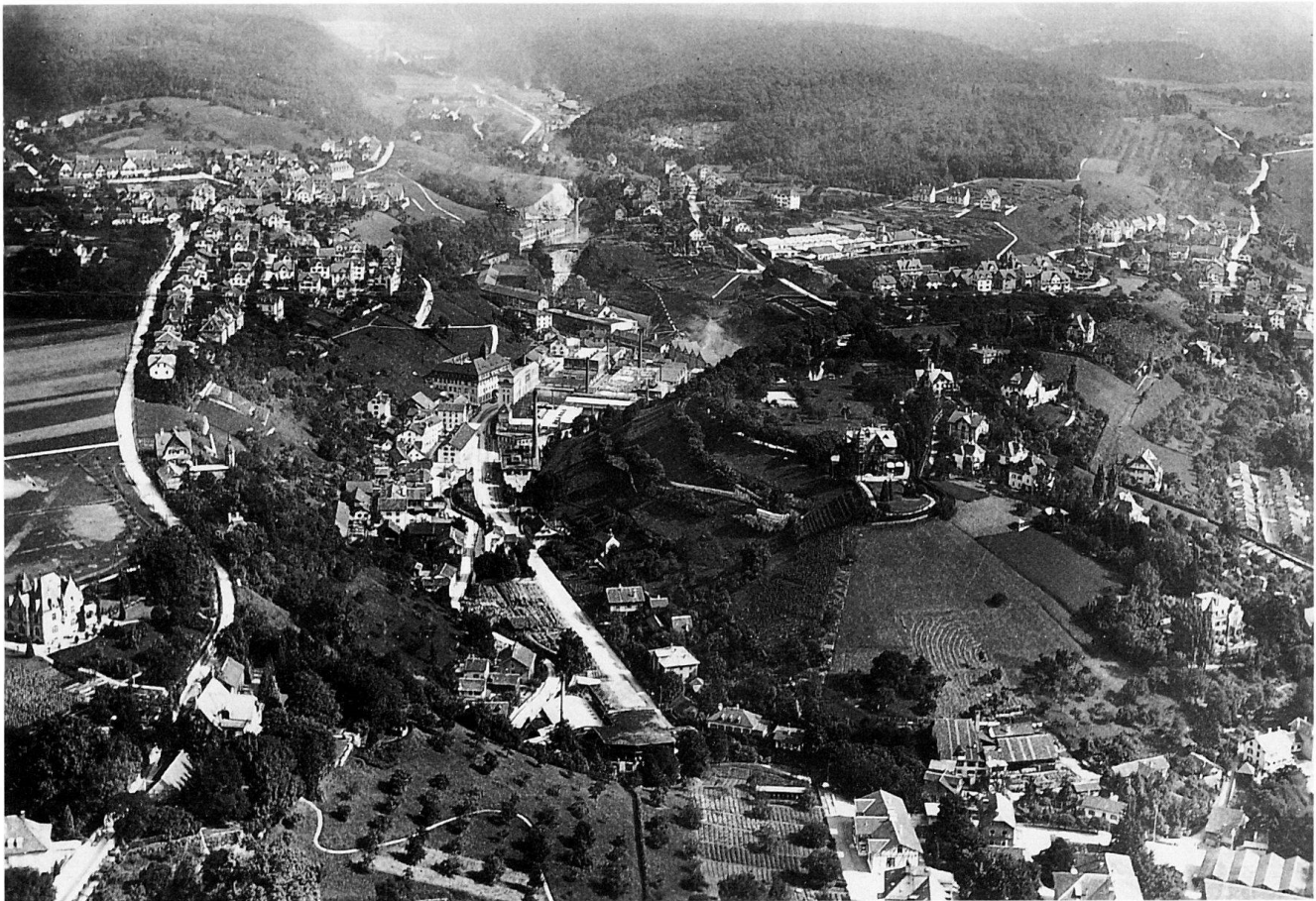
Abb. 45 Flugaufnahme des Mühlentales und der flankierenden Anhöhen von Süden, um 1920, von Walter Mittelholzer. Vorn rechts die Lagerhallen beim Bahnhof (mit Paralleldächern) und die Bauten des Spitals. In der Bildmitte die Fischerschen Stahlwerke: das Werk I mit dem markanten Verwaltungsbau (Mansardwalmdach), mit dem gegenüberstehenden «Fassadenbau» (Scheibenbau mit Türmchen) und mit der grossen Giessereihalle (rechts, mit zwei Hochkaminen); weiter hinten, wo sich das Tal zur Schlucht verengt, das Werk III mit seiner monumentalen, gekrümmten Fassadenwand. In der Talweitung des Birch (oben) das Werk IV. Links im Bild der Ostrand des Breiteplateaus, mit der ins Haultal führenden Nordstrasse. Links von der letzteren das Villenschloss des Textilfabrikanten Frey, und oben ein Teil der Irrenanstalt Breitenau (dichter Baumbestand). Rechts der Strasse die Wirtschaft Rothausturm (oberhalb der Villa) und weiter nördlich ein hauptsächlich aus den 1890er Jahren stammendes Wohnquartier, das – wie deutlich ersichtlich – im Bannkreis der GF-Werke entstanden ist; es ist mit dem Werk I durch den Breitestieg verbunden (helles Band oberhalb des Verwaltungsbaus). Zuhinterst die GF-Wohnsiedlung Schwarzadlergut, mit dem monumentalen Moserschen Zeilenbau (helle Fassade, oben links). Rechts im Bild der Geissberg, nach Osten (rechts) zum Fulachtal abfallend. Die Südspitze des Geissbergs ist – nach der Steig und dem Stockarberg – die zweite bedeutende Villenzzone der Stadt. Auf der Kuppe die Villa Berg von Georg (III.) Fischer mit ihrem weitläufigen Park und mit der Serpentinstrasse, welche zu den Stahlwerken hinunterführt. Weiter oben im Bild das GF-Werk Geissberg, von Georg Fischer nach seinem Ausscheiden aus der Firma als Elektrostahlwerk aufgebaut und dann an die GF verkauft. Rechts aussen, oberhalb der Villa Tannerberg, die Reihenhäuser im Rittergut: die erste Arbeitersiedlung in Schaffhausen.
